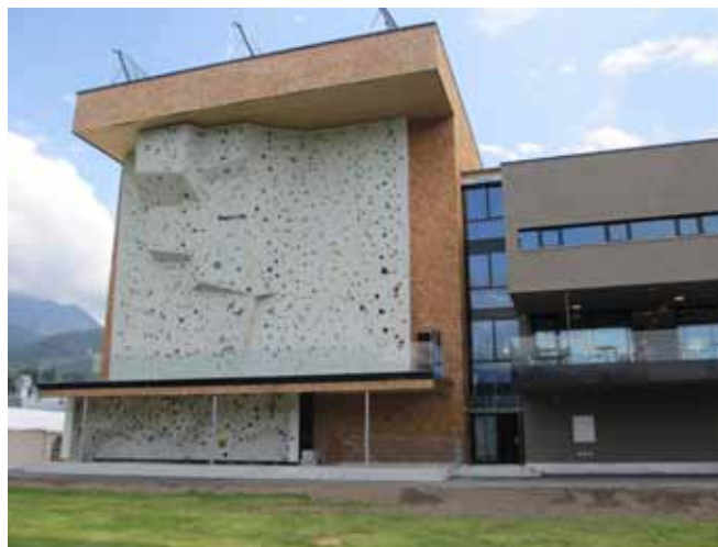
Стената за катерене в Заалфелден до Залцбург – едно от съоръженията на фирма „Уолтопия“ Kletterhalle Saalfelde, Saalfelden Am Steinernen Meer, Salzburg – ein Projekt der Firma Walltopia
